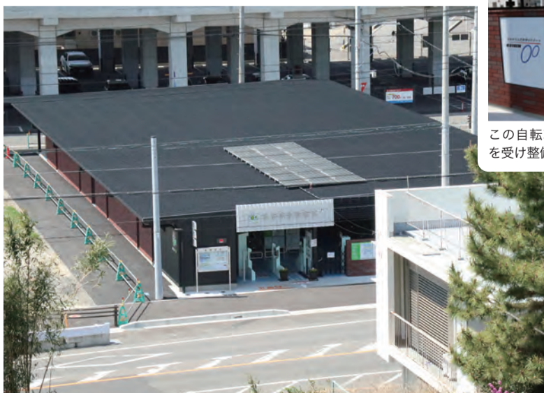
屋根には太陽光パネル。場内に蓄電池も設置され、夜間照明等の電力を供給。
