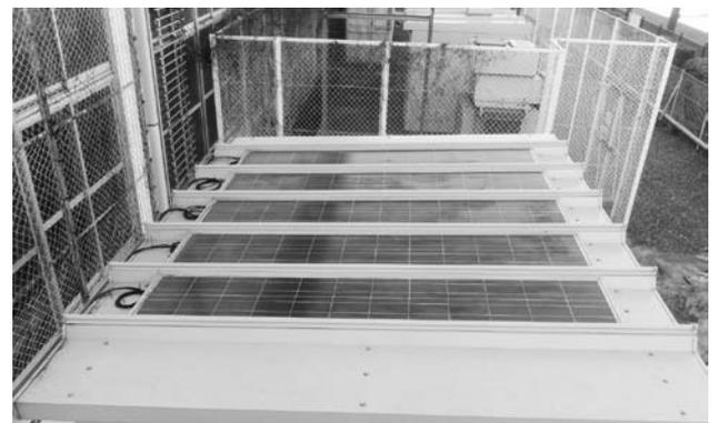
ソーラーパネルで発電した電力を蓄電システムに貯め、夜間照明設備に活用するサイクルルーフ
