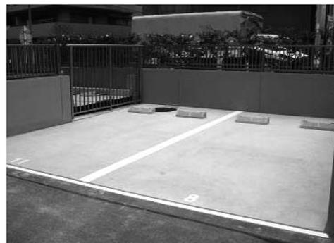
コンクリート製床を利用した機械式駐車場の平面化工事
