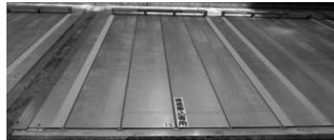
鋼板製床を利用した機械式駐車場平面化工事
