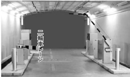
四輪車の車路に二台のゲートを併設
