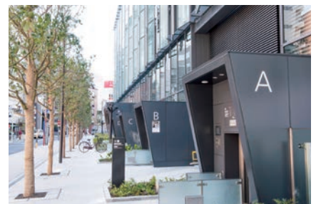
入出庫口(ビル併設)
